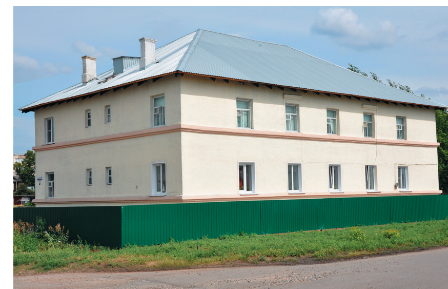
Алтайский край, село Кулунда. Многokвартирный дом после проведения капитального ремонта
